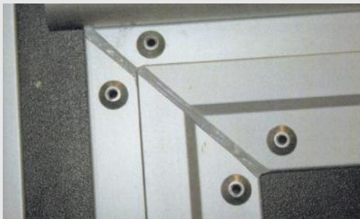
Türen mit Einfassung aus eloxiertem Aluminium, Ecken mit MS-Polymer abgedichtet
